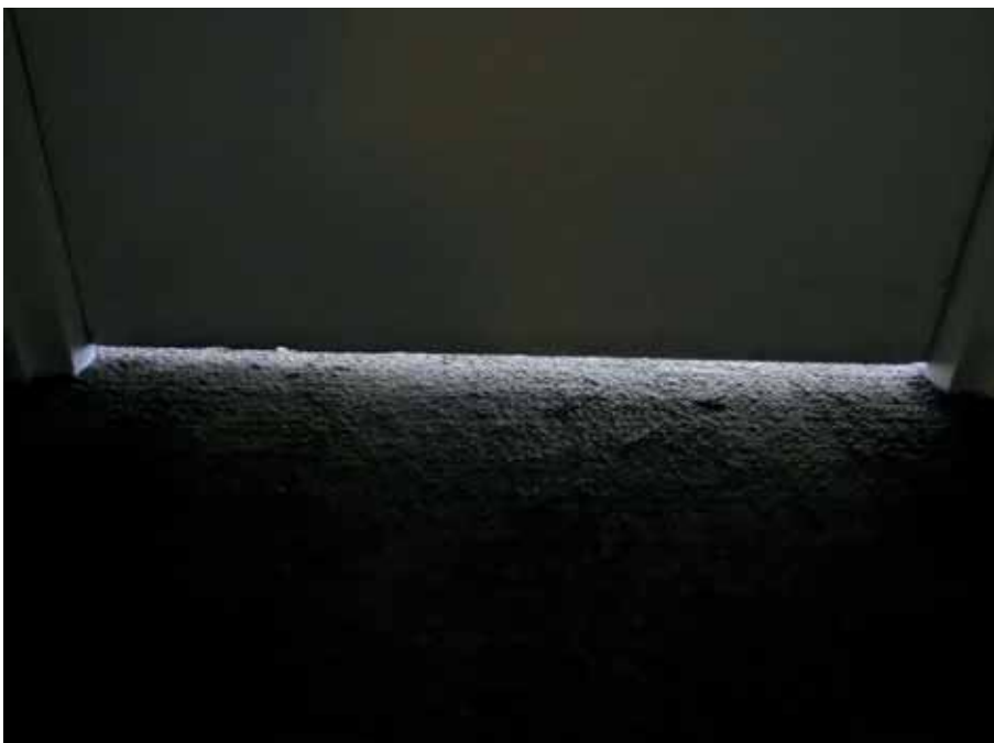
Er zat een (naar huidige maatstaven) wel erg grote kier onder de deur.
